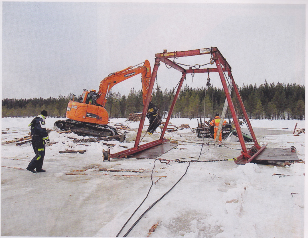
Den egentillverkade isbocken klarar sig bra på isytan och kan fördela vikten väl. Foto: Ume Assistance
